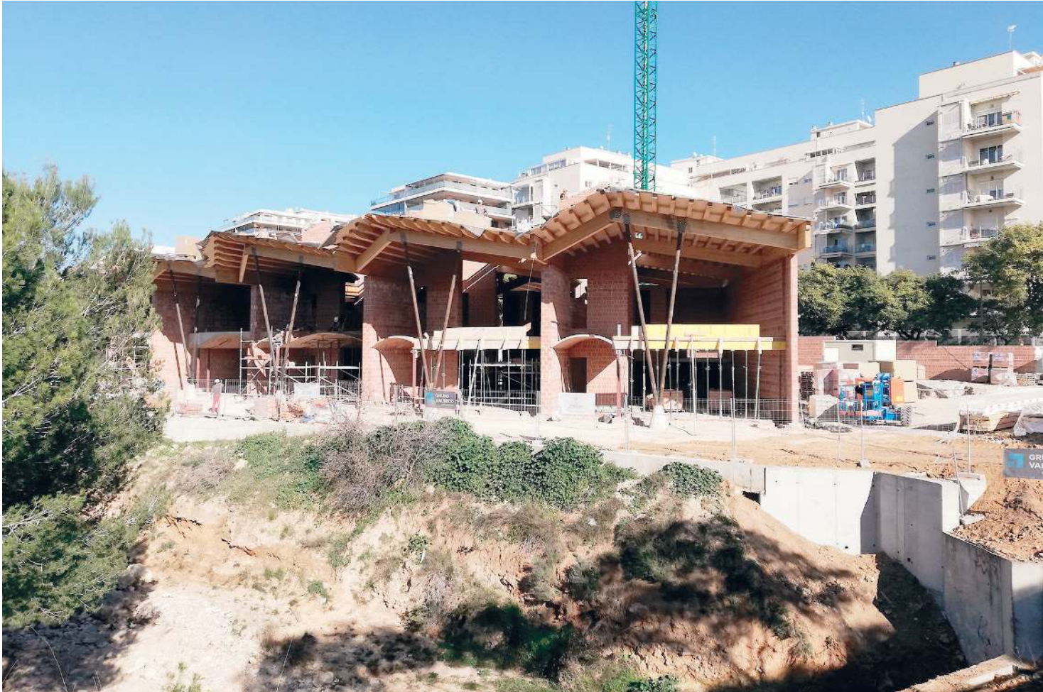
Der Bau der Schule am Stadtrand von Paterna ist bereits voll im Gange.
